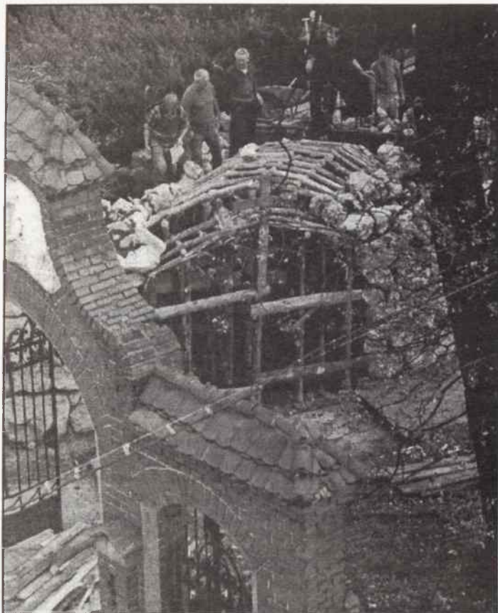
Grota podczas budowy
