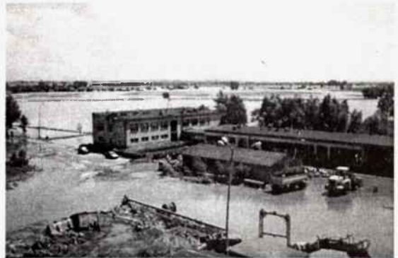
Budynek administracyjny wraz z zapleczem po opadnięciu wody
